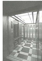
写真6 扉の開閉方向を音声で知らせる通り抜け型エレベーター
