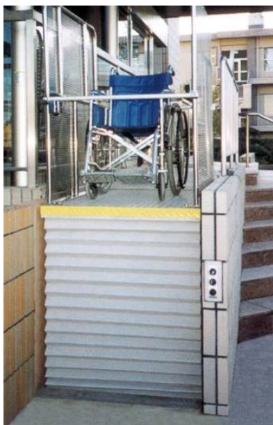
・鉛直型段差解消機
