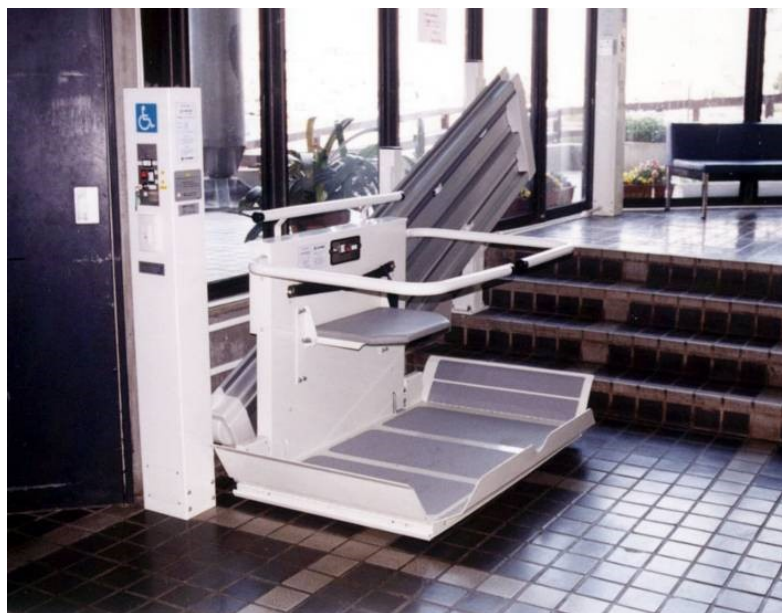
・既存施設のホール部分の階段に設置された斜行型段差解消機
