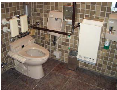
G EVホール UD化トイレ
