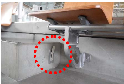
・観覧席の下部に設けられた磁器ループシステムの補聴器用アンテナ線の接続端子
