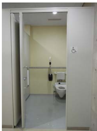
・女子トイレ内に設けられた広めの便房（車いす使用者用簡易型便房）
