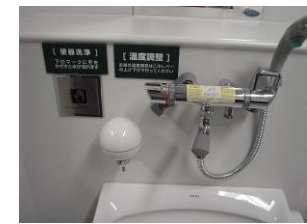
オストメイト設備
