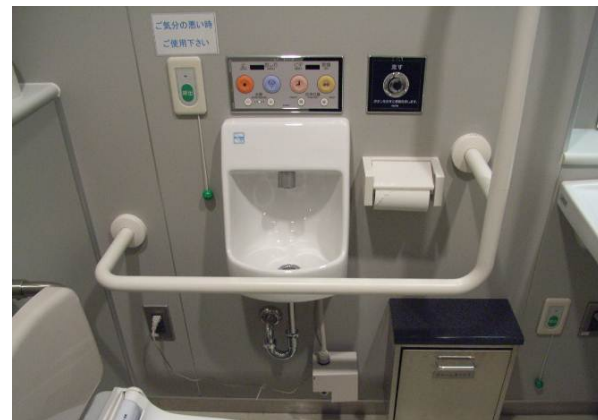
・操作系設備配置 JIS S0026規定
