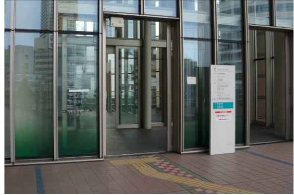
・視覚障害者誘導用ブロックの敷設と併せて、音声案内設備が設置されている建築物の出入口
