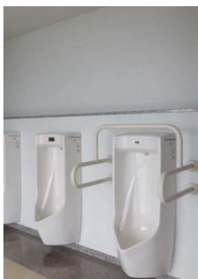
・手すりが設けられた小便器
