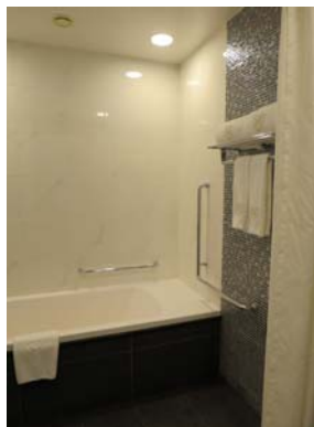
・移乗台及び手すりを設けた浴槽
