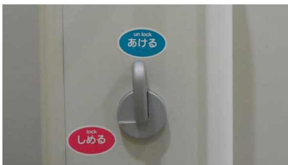
・便房に設けられた大きめのレバー錠、色による戸の施錠／開錠表示（点字表示付）
