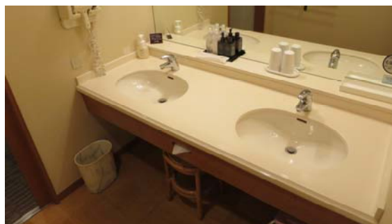
・下部に車いす使用者の膝が入るスペースを確保した洗面台
