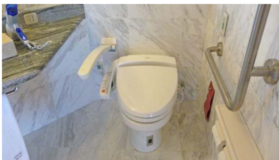
・両側に手すりを設けた便所
