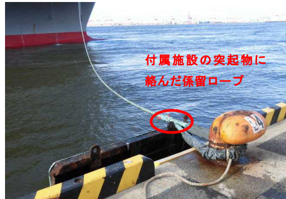
写真8：付属施設に絡んだ係留ロープ
