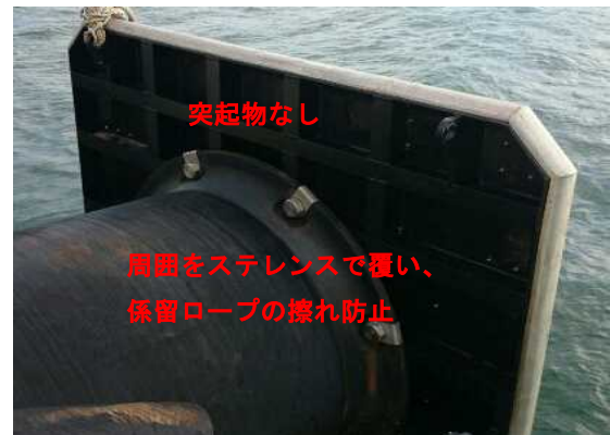
写真10：係留ロープが絡みにくい対策をした付属施設
