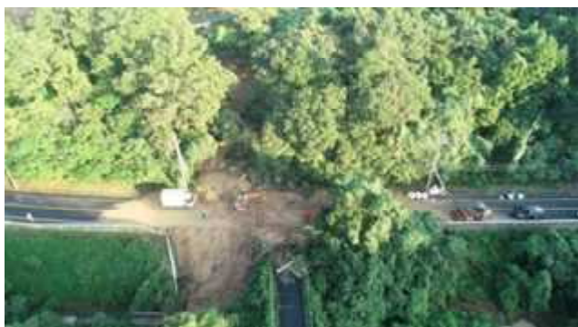
県道 とつとりしかのくらしせん 鳥取鹿野倉吉線（鳥取県鳥取市） 法面崩壊
