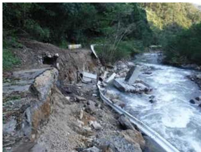
主要地方道 みやこのじょうくしません 都城串間線（宮崎県都城市） 護岸及び道路崩壊
