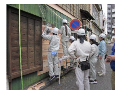
腰壁の木質化修復実習の様子
