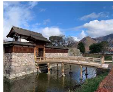
太鼓門前橋外整備工事
