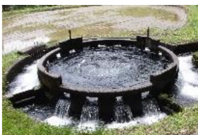
音無井路12号分水
