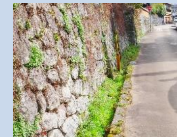
老朽化した市街地導水路の現状
