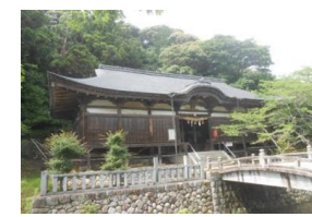
▲春日神社拝殿解体修理事業
