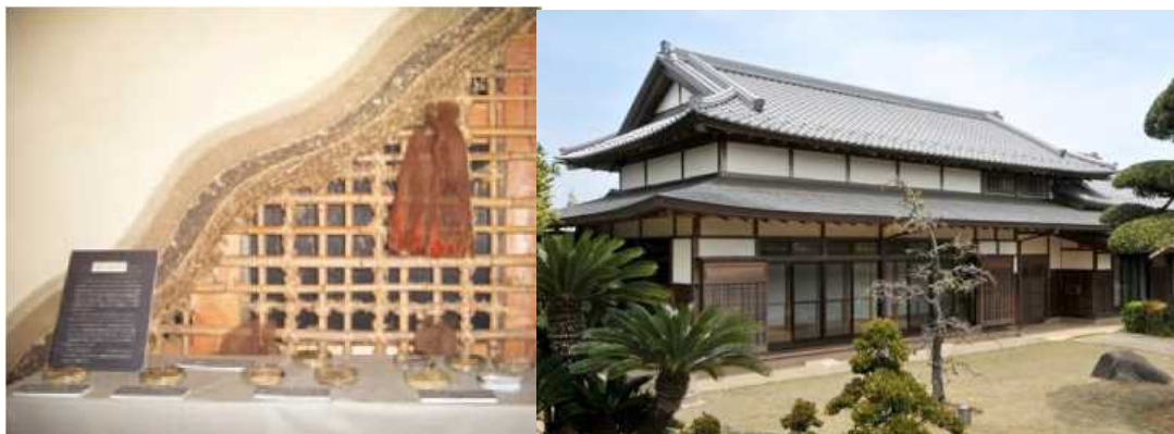
〈両側真壁の土塗壁の採用〉
