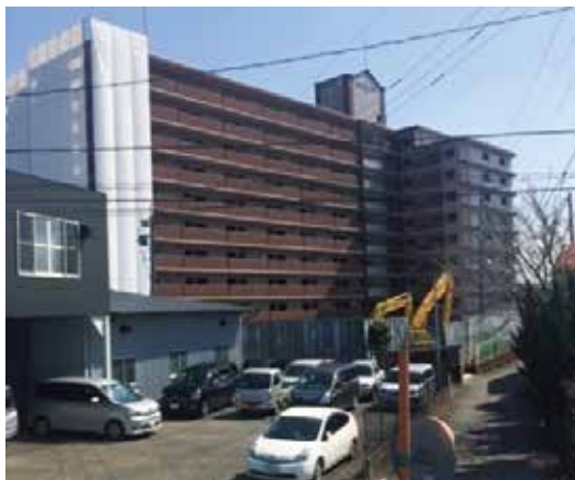
解体中のマンション全景
