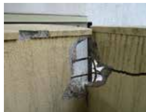
[写真08] バルコニー手摺壁損傷状況
