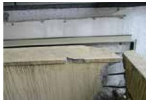
[写真06] バルコニー手摺壁アンクル
