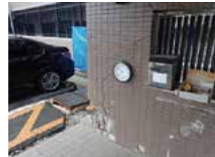
[写真05] 杭基礎被災建築物1階参考写真
