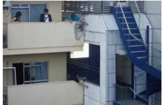
下げ振りを使用した実測状況
