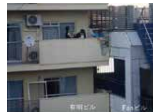
[写真09] バルコニー手摺壁損傷状況（外観）
