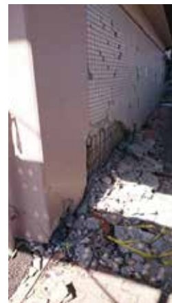
解体中マンション近景 2018.02.26撮影
