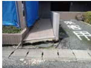
[写真04] 杭基礎被災建築物周辺参考写真
