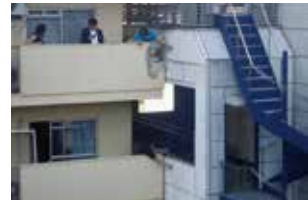
[写真03] 下げ振りを使用した実測状況
