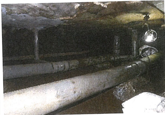
トンネル工法による配管例 2
