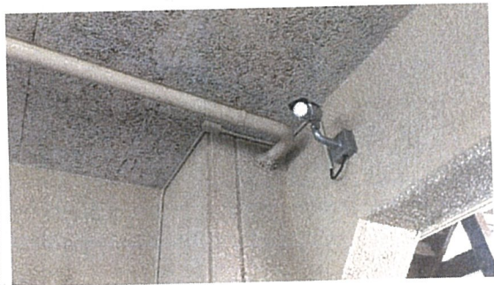
607号室からの排水管状況 2
