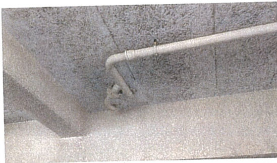
607号室からの排水管状況 1
