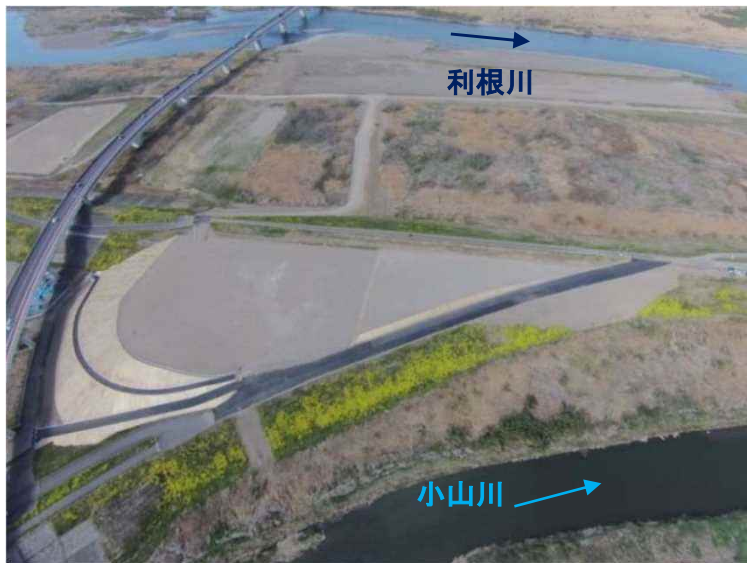
下高島地区(埼玉県深谷市)
