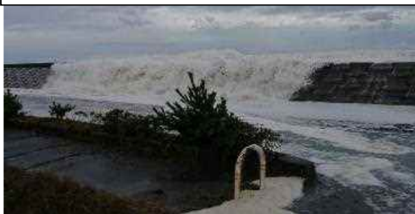
高潮による堤防越波状況
