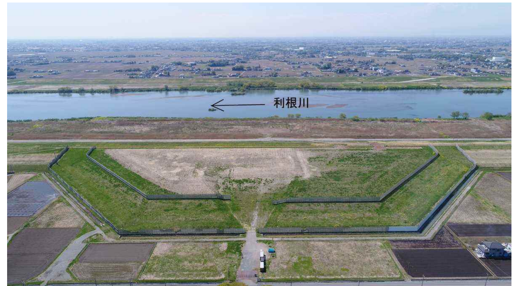
栄地区広域避難地(埼玉県加須市)
