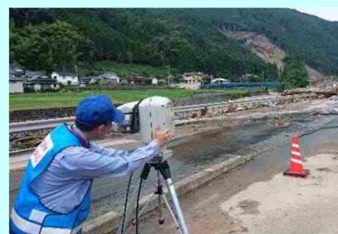
斜面崩壊箇所の調査(日田市)
