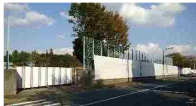
【H30. 10月現在の対象工事現場の状況】
