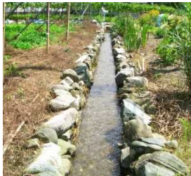
雄川堰(小堰) (群馬県甘楽町提供)
