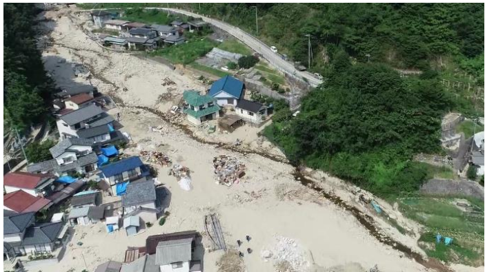
土砂・洪水氾濫(今次洪水)
