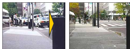
段差、傾斜、勾配の改善
