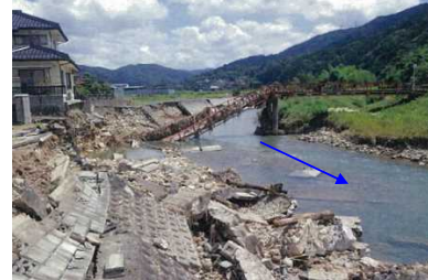
橋梁の被災状況
