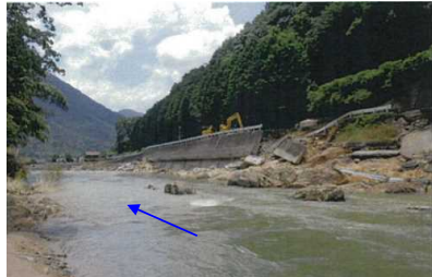
護岸の被災状況
