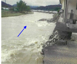
家屋の被災状況
