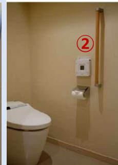
② 便房の垂直手すり
