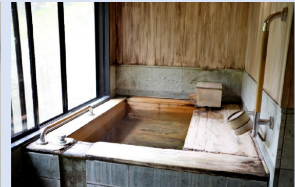
・移乗台及び浴槽出入りのための手すり、浴槽内の立ち座り、姿勢保持のための手すりを設けた浴槽
