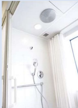
・上下2箇所に設けたシャワーヘッド掛けと横手すり
