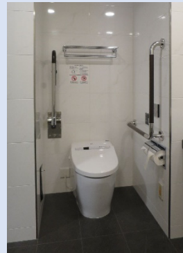
・L型の手すりと跳ね上げ式の手すり
