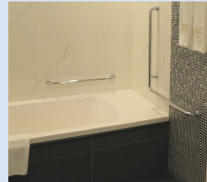
・移乗台及び浴槽出入りのための手すり、浴槽内の立ち座り、姿勢保持のための手すりを設けた浴槽
