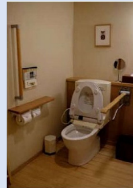
・縦手すり、水平手すり兼用の紙巻き器、跳ね上げ式の手すり
