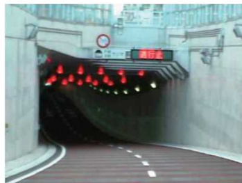
坑口部フラッシング*
