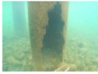
▲パイルベントの断面欠損
