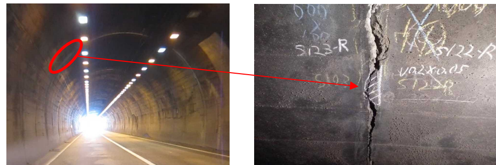
目地部のうき・はく離
