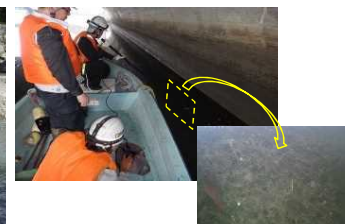
▲水中カメラによる定期点検
