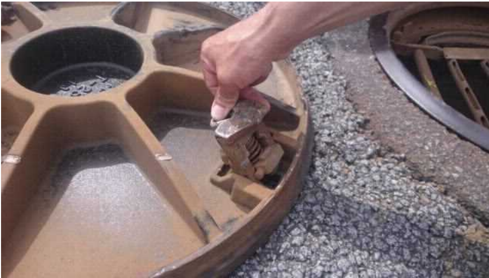
マンホール蓋裏面
