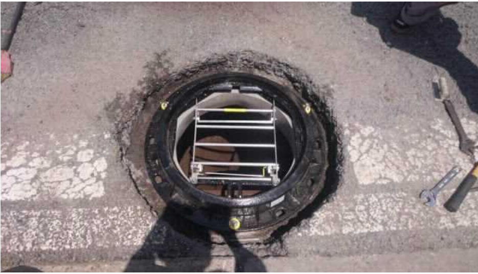
コンクリート打設前
