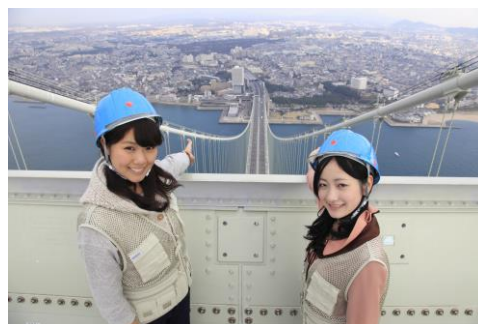
明石海峡大橋（兵庫県）
