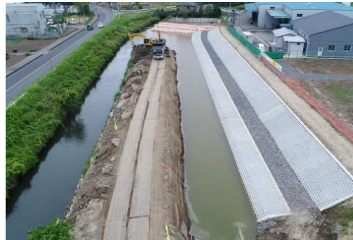
＜UAVによる進捗写真＞
