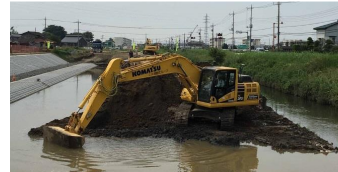
＜ICT建機による出水期の河床掘削＞
