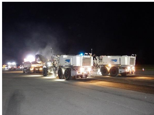
＜路面切削自動制御＞
