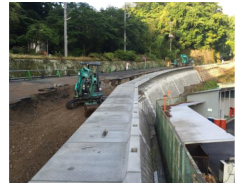
＜プレキャスト構造物の設置＞ (現場の位置出しが不要に)
