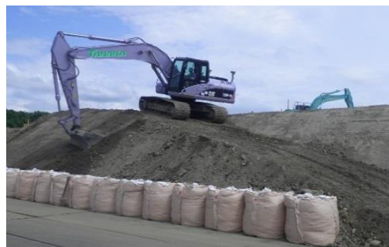
<仮設搬入路の築造>
