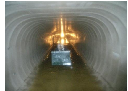
改築工事の一例
