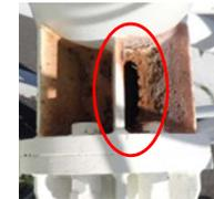
固着した腐食片を取り除いた状態の例
