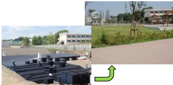
公園広場の地下に埋設されている雨水貯留施設 (世田谷区ホームページより引用)
