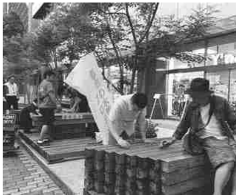
写真5 都市の木質化プロジェクト「ストリートウッドデッキ」を補修する「まちメンテ」の様子
