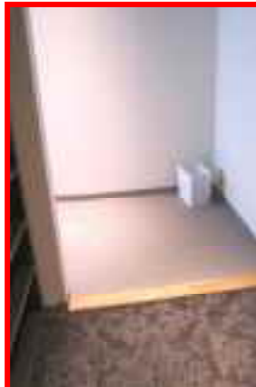
・上り框の前後に段差を設けず、仕上げ材に変化をつけて履き替え線を示した脱衣室
