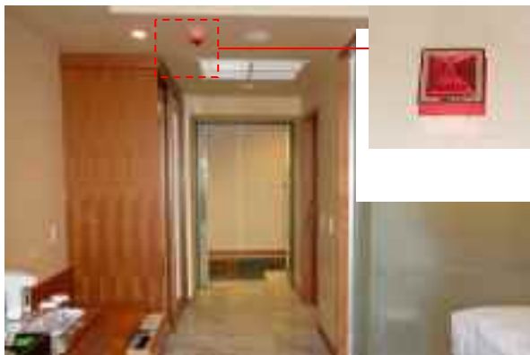
・天井に設置された聴覚障害者への情報伝達のための非常表示灯
