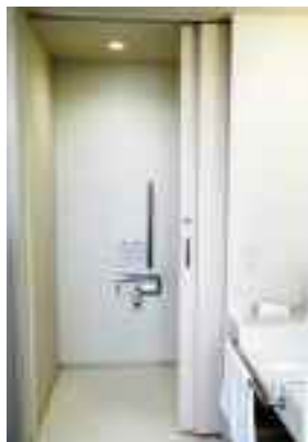
・便所の出入口の2連引き戸
