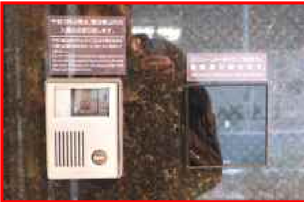
・ 出入口に設けられたカメラ付きインターホン（点字併記つき）
