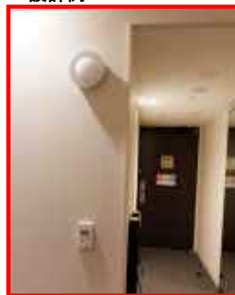
・壁に設置された聴覚障害者への情報伝達のための非常表示灯
