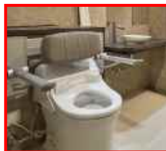
・着脱式手すり
