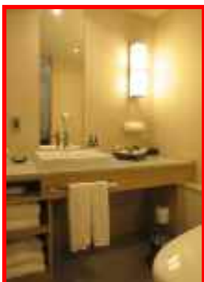
・下部に車椅子使用者の膝が入るスペースを確保した洗面台
