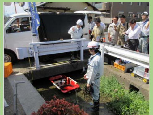
橋梁点検支援技術(狭小部)
