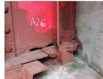
桁端部の腐食・貫通
