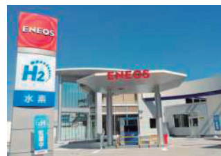
水素供給設備
