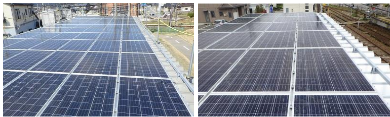
変電所屋根部
