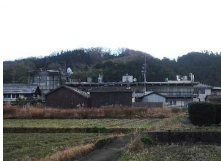
既存不適格建物の役場庁舎
