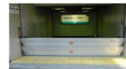
【地下鉄駅の止水版による浸水対策】
