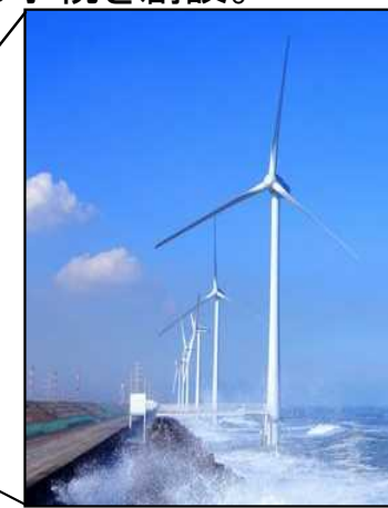
洋上風力発電施設
