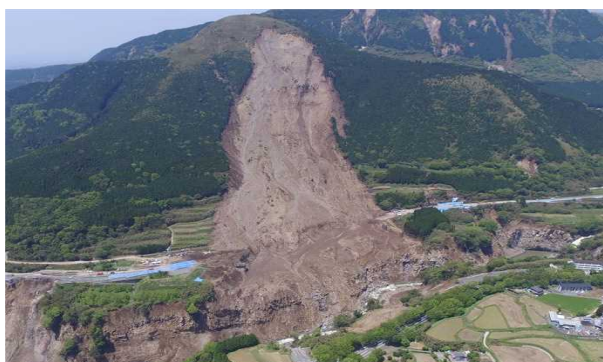
【斜面崩壊に伴う国道等閉塞の状況】 (熊本県南阿蘇村)
