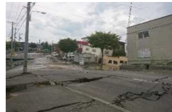
【宅地被害の状況】 (北海道札幌市清田区)
