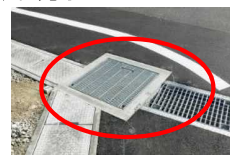
道路上の排水施設
