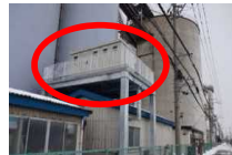
電気設備の嵩上げ
