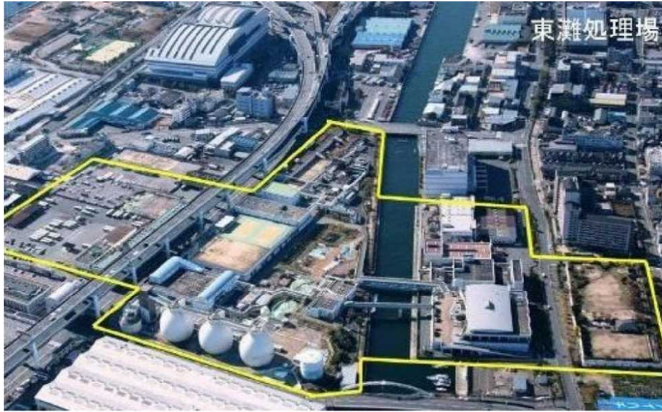
図資 2-3-14 神戸市東灘処理場の全景 1)
