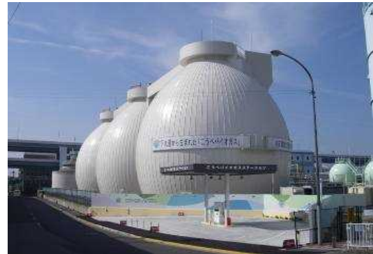
図資 2-3-17 消化槽の状況
