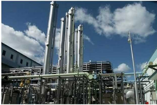
図資 2-3-16 精製設備の状況 6)
