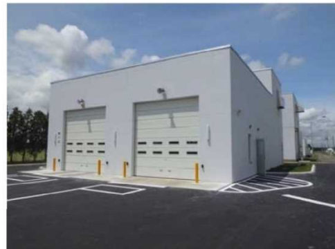
▲生ごみ処理施設(生ごみ搬入口)
