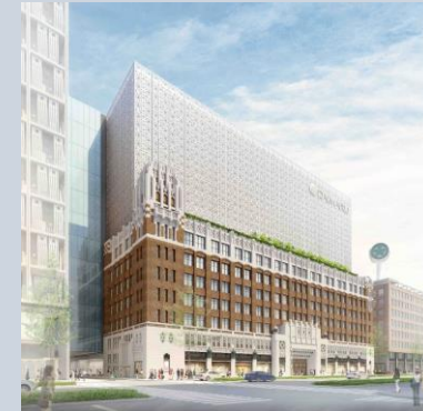
大丸心齋橋店 御堂筋に残る大阪の歴史や文化を継承 (ヴォーリズ建築:御堂筋側の外壁を保存)
