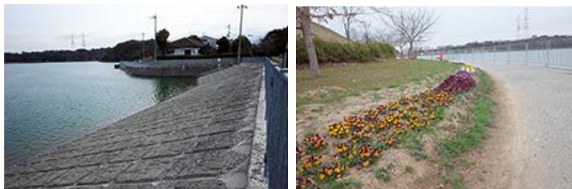
改修した副堤防（平成30年3月撮影）
