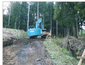
工事中（起点部分）
