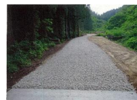
整備後の林業専用道
