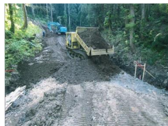
工事中（中間部）
