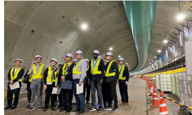
＜NEXCO中日本：東京外環大深度地下シールドトンネル工事＞
