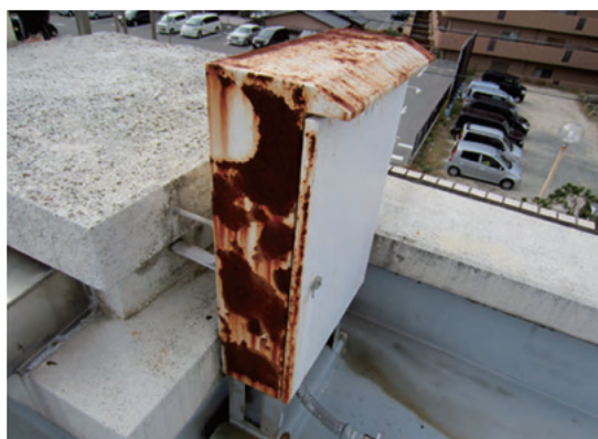
屋外電力盤の発錆
