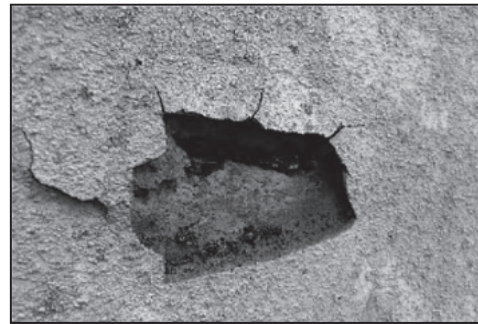
鉄筋の腐食
