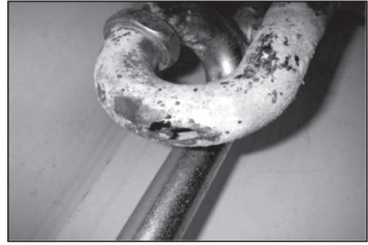
排水トラップの劣化
