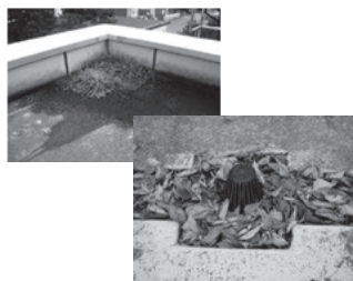
ルーフトレンの清掃不良
