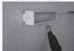
非常用照明の不点灯
