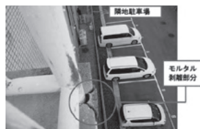
屋外階段手すり部の異常
