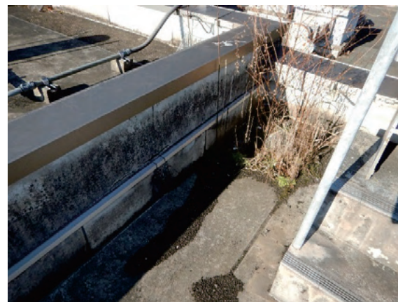
屋上の目地に生えた植物
