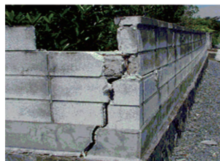
ブロック塀のひび割れ・傾き
