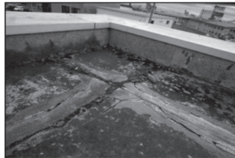
防水押さえコンクリートの損傷
