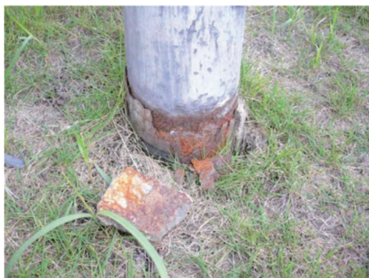
外灯支柱の腐食
