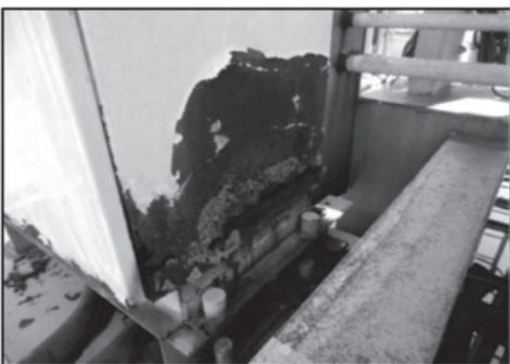
屋外制御盤のさび
