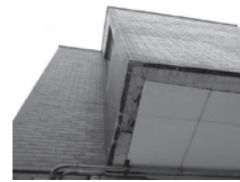
外壁タイルの異常
