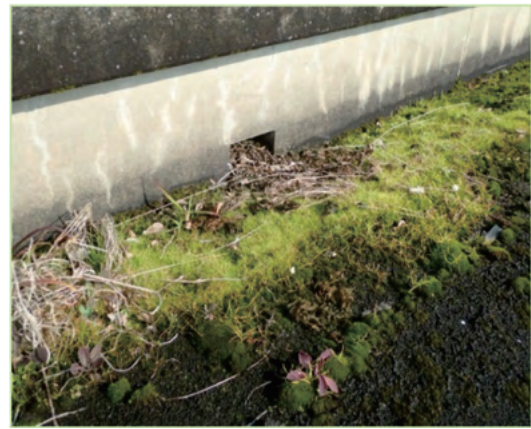
排水口に溜まった泥やゴミ
