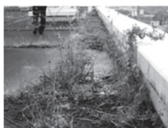
屋上目地部の雑草
