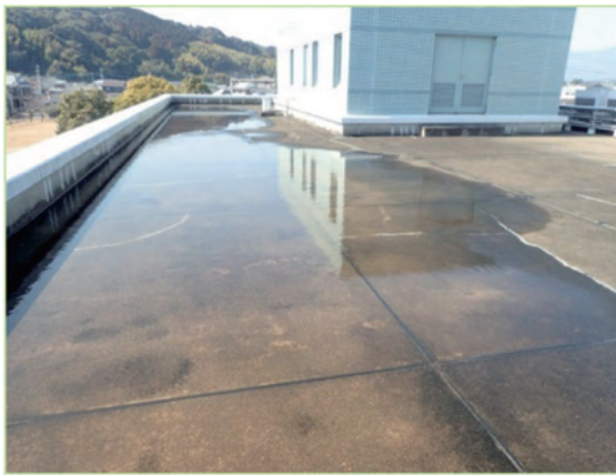
雨水の溜まった屋上
