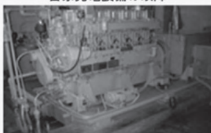
自家発電設備の故障
