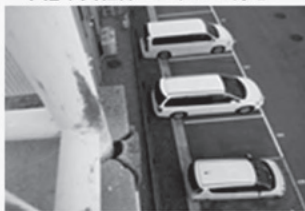
手摺り支柱部モルタルの浮き
