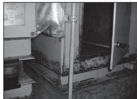
ユニット形空調機の腐食
