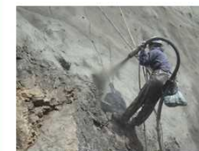
仮設用モルタル吹付状況
