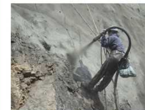
仮設用モルタル吹付状況
