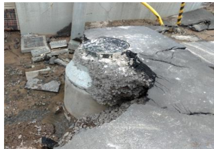
液状化による管路の被害(イメージ)
