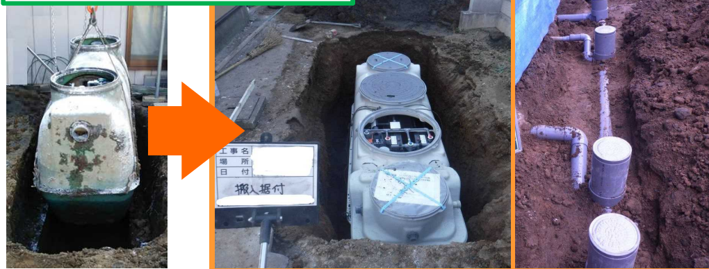
単独浄化槽撤去
