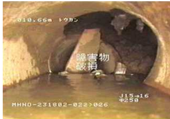
破損した管路
