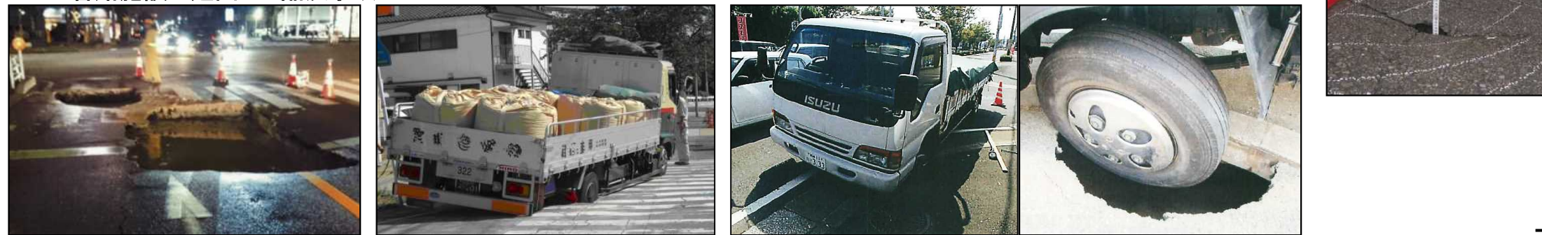
● 管路施設に起因した陥没事故
