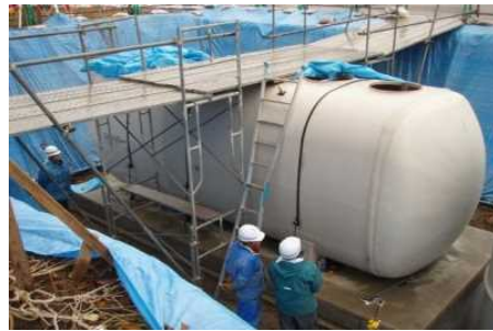
工場製作型 極小規模処理施設
