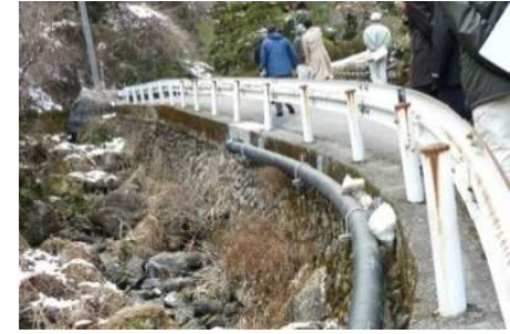
クイック配管 (露出配管)
