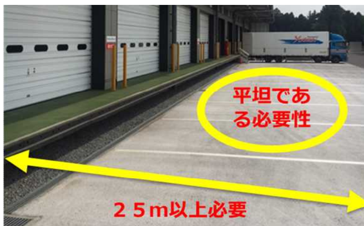
【図1-7：バースの接着幅のクリアランス】
