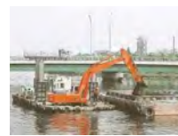
河川浚渫工事
