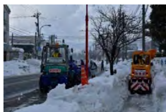
歩道除雪（福井市）
