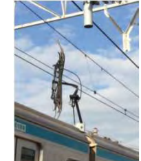
架線工事での施工不良によるパンタグラフの損傷 (出典:JR東日本)
