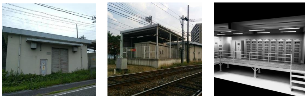
(図3. 左:旧宮島変電所建物 中:宮島変電所 右:装置設置イメージ)
