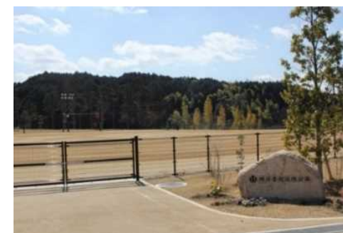
生活基盤の整備
